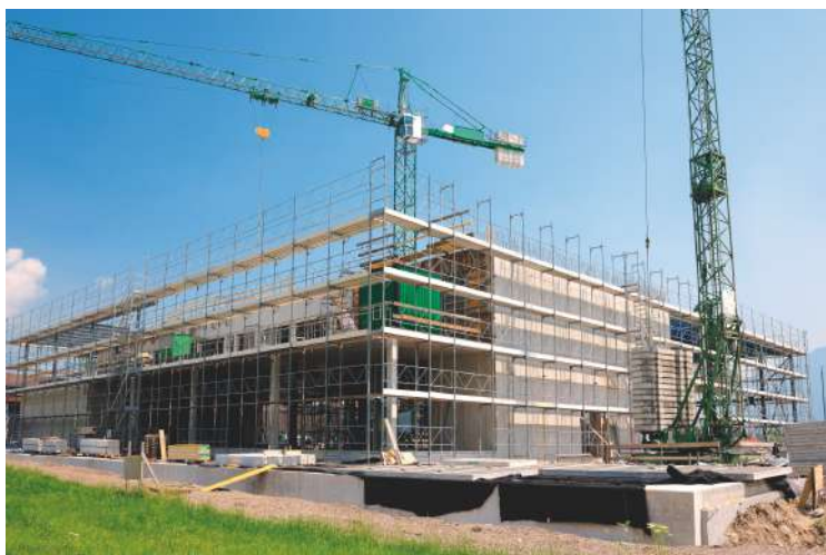
Foto Construcción General Gentiliza BU Firestop Hilti.
