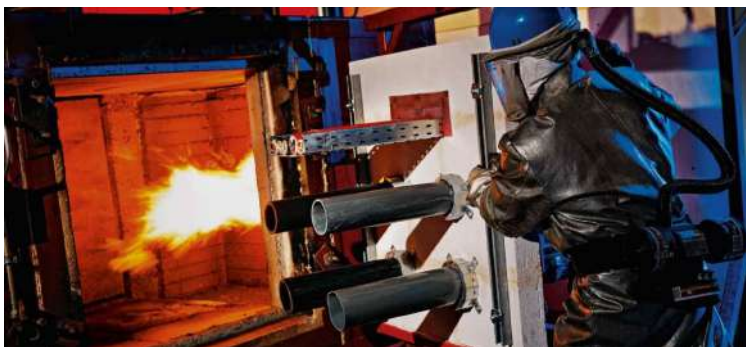
Figura 1: Prueba a sistemas de sello de penetraciones, Cortesía Hilti Chile
