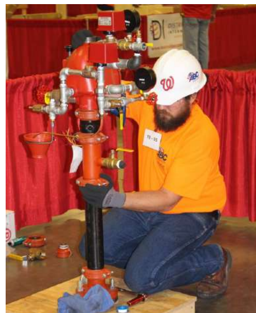
Entrenamiento de armado válvula sistema de rociadores
