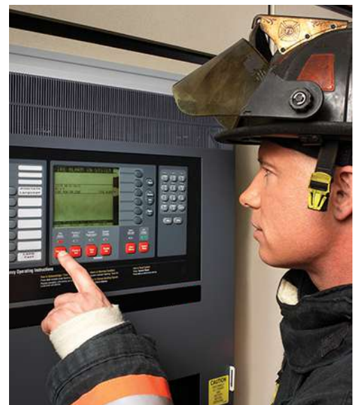
Recepción de sistemas de detección.
