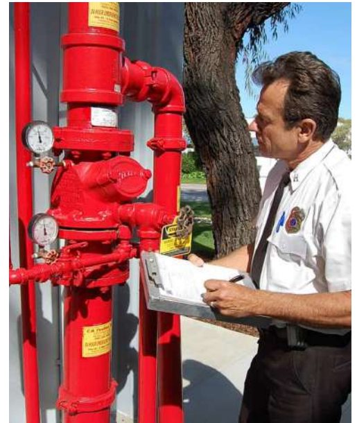
Revisión de sistema de rociadores.
