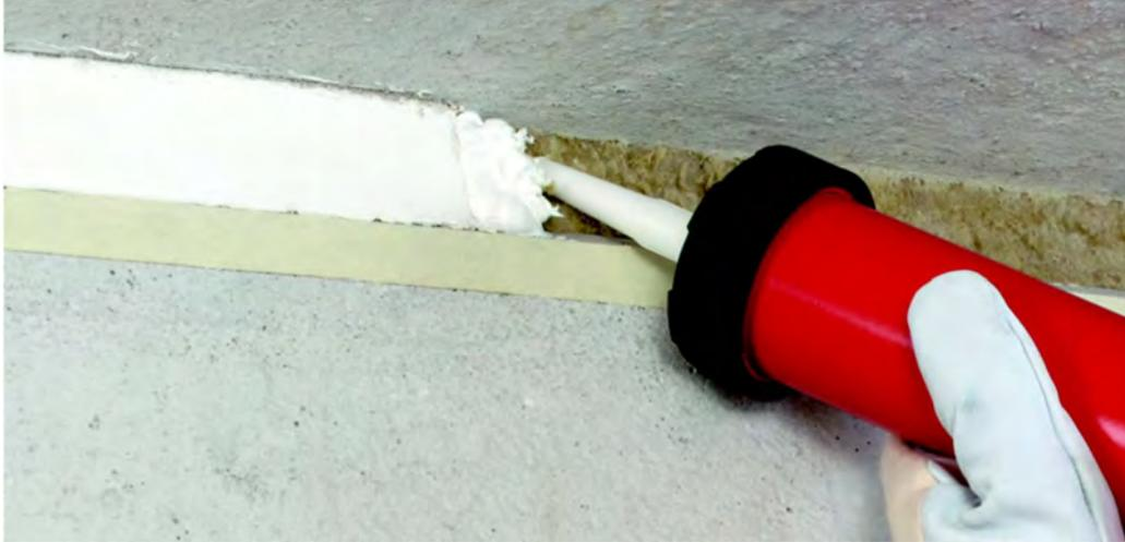
**Figura 49. Junta en la parte superior de muros**
