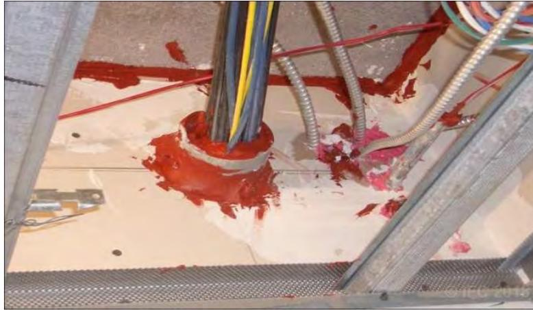
**Figura 26. Instalación incorrecta: combinación de productos cortafuego**
