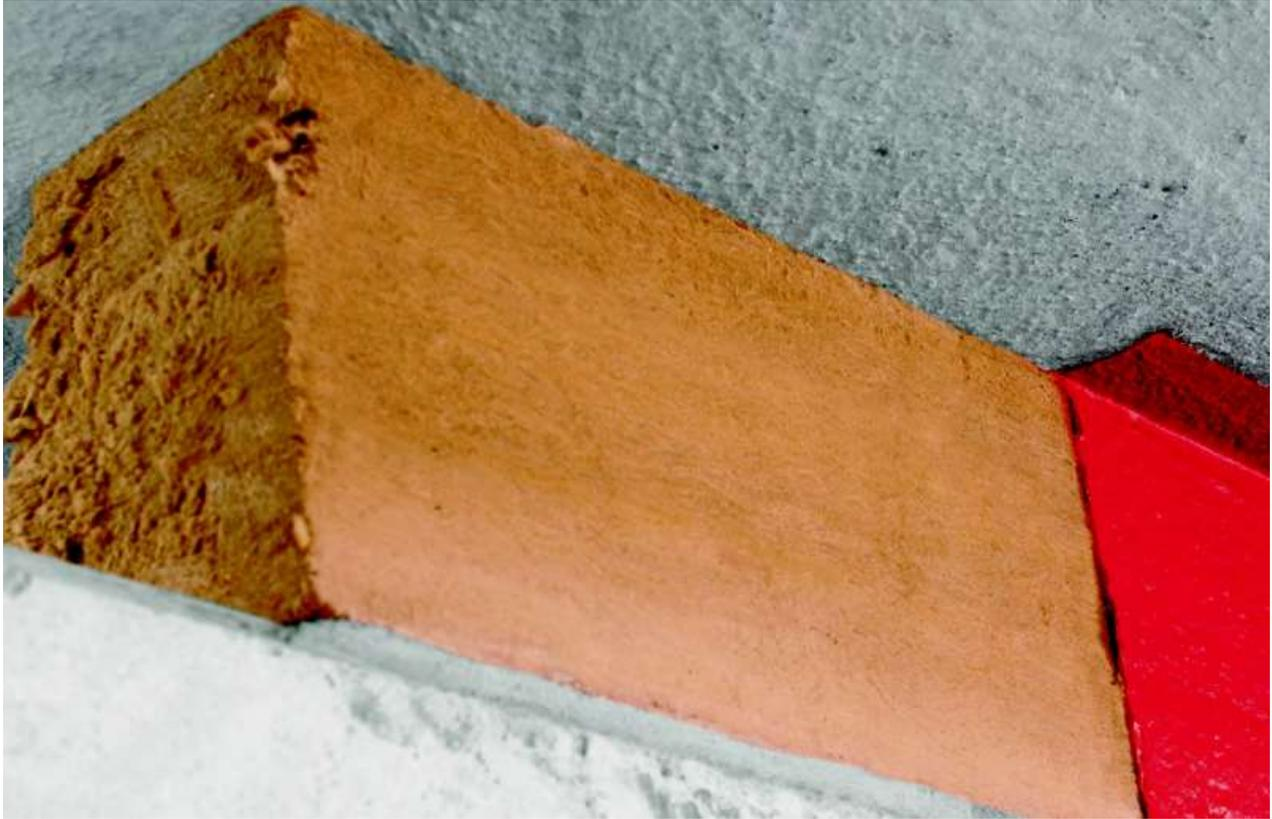
*Figura 45. Ejemplo de sello en junta constructiva*
