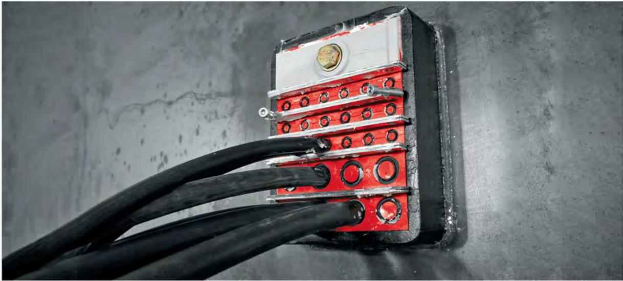
*Figura 91. Sistemas de tránsito de cables cortafuego para industrias*
