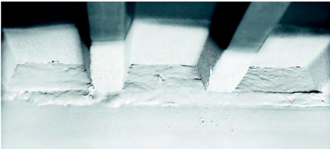
**Figura 48. Junta en muro-losa colaborante**
