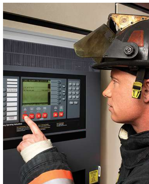
Recepción de sistemas de detección.
